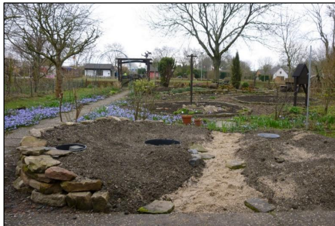
Abb. 4: Anlage der Natursteinmauer 14.04.2013
